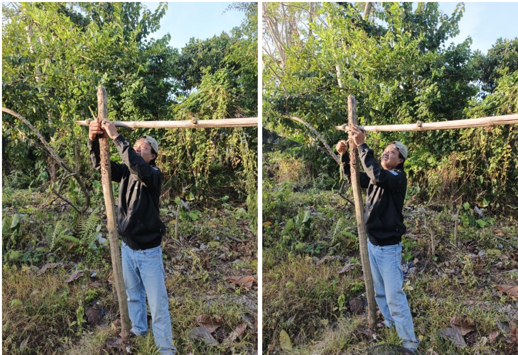
Gambar 2. Pembuatan rangka rumah pembibitan
